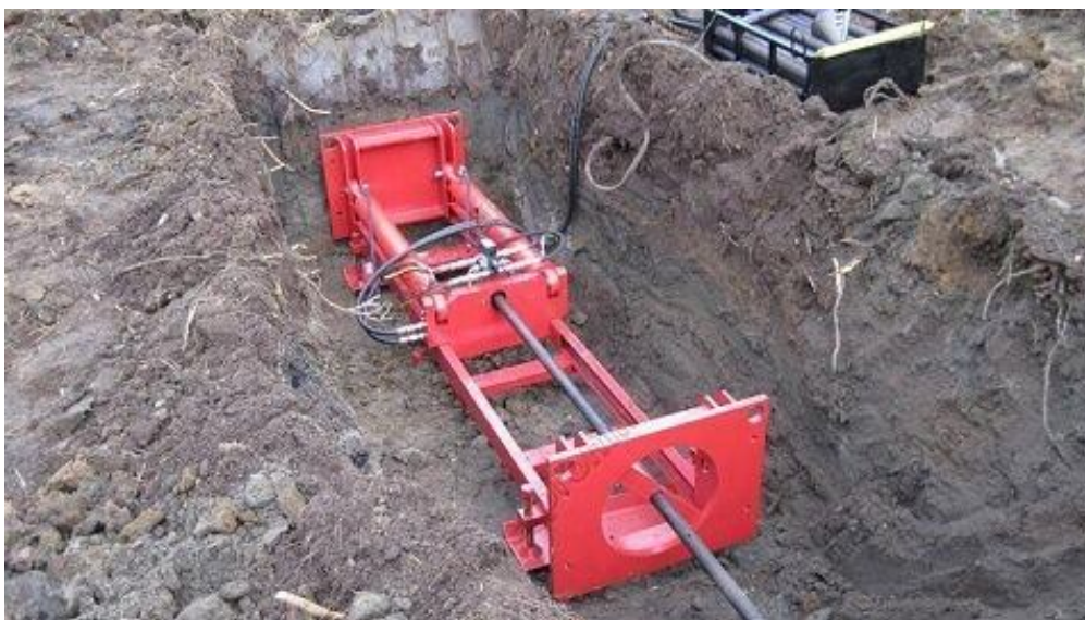
Рис. 3.66. Установка для прокладання кабелю методом проколу
