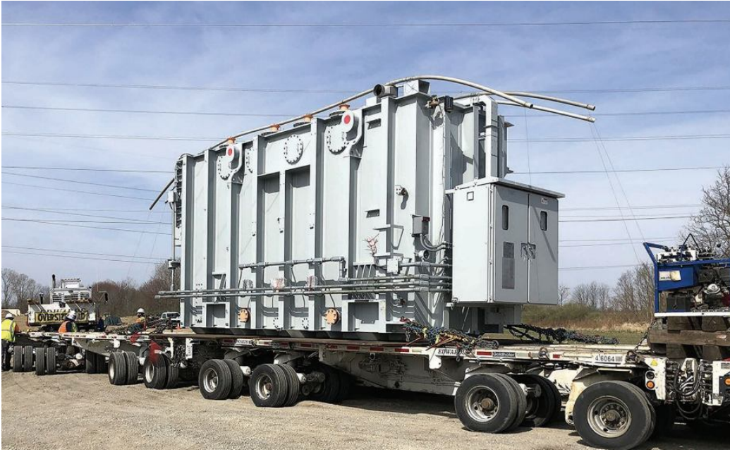
Рис. 4.21. Транспортування автотранспортом корпусу автотрансформатора з осереддям та обмотками до місця установки
