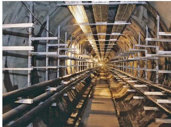
Рис. 3.63. Розміщення кабелів та трубопроводів у круглому каналі: a – ескіз розрізу каналу; б – вигляд у натурі
