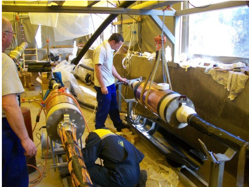
Рис. 3.56. Монтаж з'єднувальних муфт кабельної лінії 330 кВ
