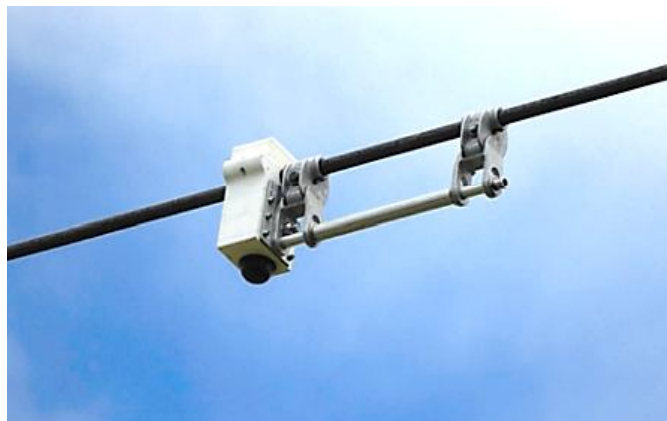
Рис. 4.6. Метеостанція для контролю за температурою провода ЛЕП та навколишнього середовища
