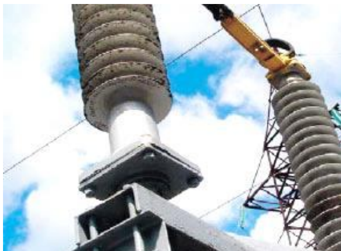
Рис. 3.28. Ізолятор, покритий колоніями грибків
