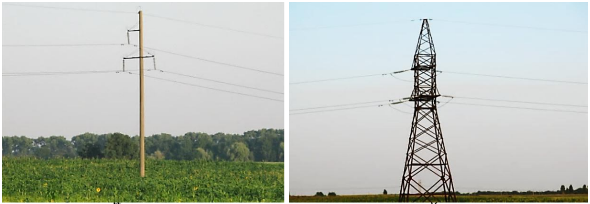
Рис. 3.3. Повітряна ЛЕП напругою 110 кВ: a – проміжна опора; б – анкерна опора
