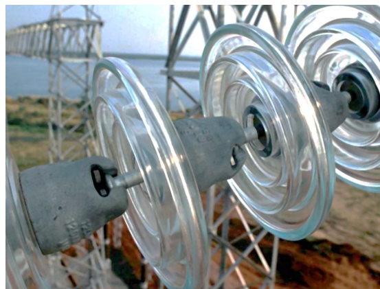
Рис. 3.10. Скляні ізолятори: а – штировий; б – тарілчатий (вид знизу); б – тарілчатий (поздовжній розріз); г – тарільчаті скляні ізолятори скріплені в гірлянду
