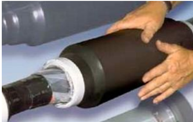
Рис. 3.50. Епоксидна муфта
