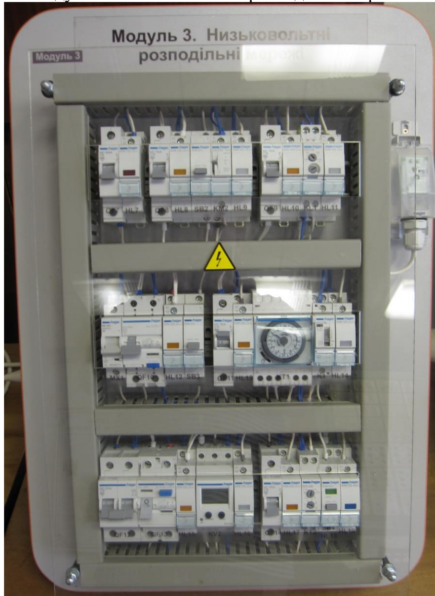
Модуль 3. «Низьковольтні розподільні мережі»
