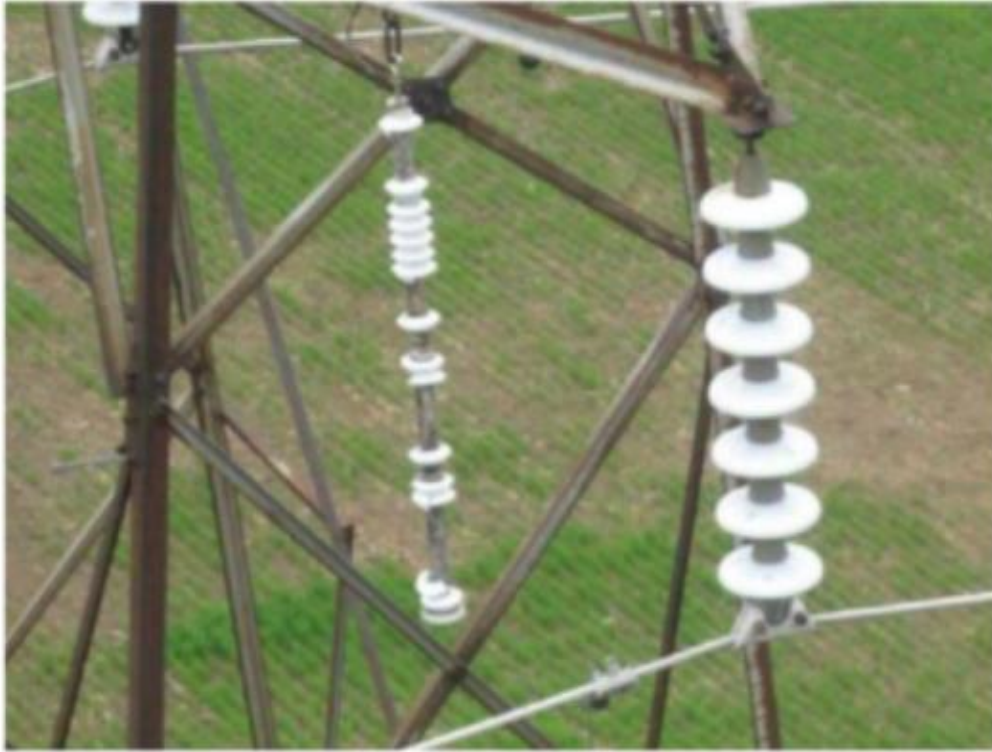
Перевантажений ОПН без іскрового проміжку
